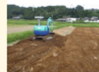
土層改良（客土）
