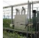
ヒートポンプ
