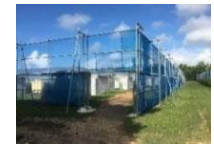
防風ネットの設置
