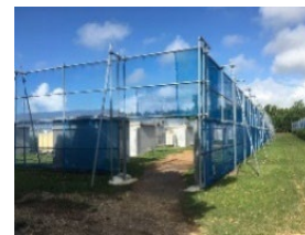
防風ネットの設置
