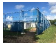
防風ネットの設置
