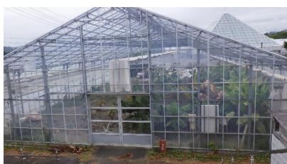
システムが設備されているハウス
