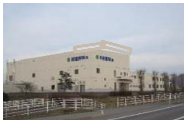
米粉製粉工場
