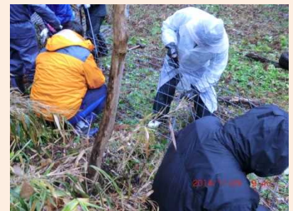
地区住民による防護柵設置作業
