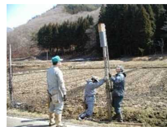
防護柵の補修活動
