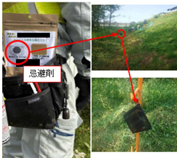
事例 1（工事現場に忌避剤を設置）
