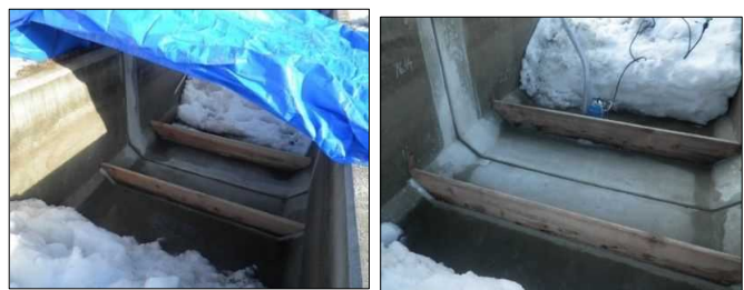
目地の上下流側に止水対策を行うことによる施工性、品質の向上
