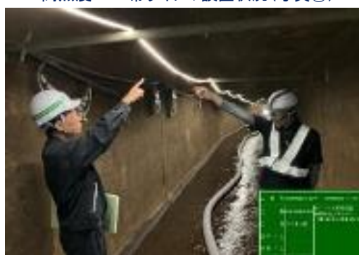
高照度LED帯ライトの設置状況(写真①)
