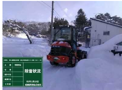
近隣住宅道路の除雪 (R2工事)
