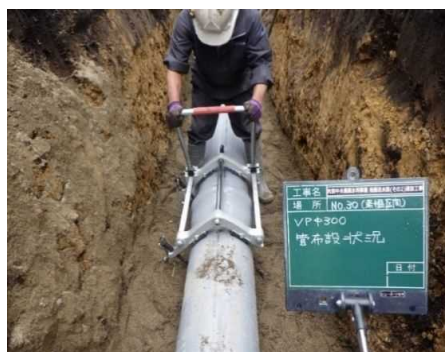
パイプ挿入機による施工状況(1)
