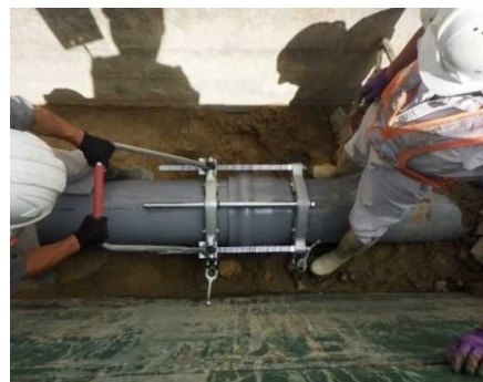
パイプ挿入機による施工状況(2)
