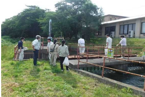
(下堰幹線用水路)
