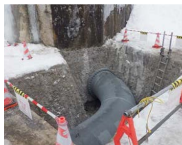
導水管の据付状況
