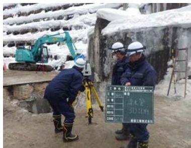
現場での導水管の3Dスキャン状況
