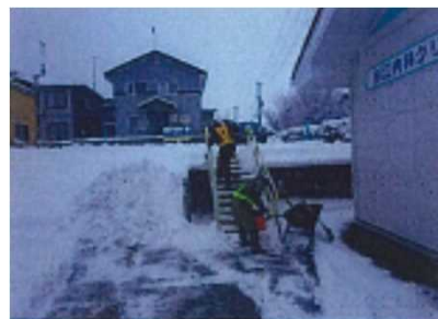
現場付近道路の除雪作業
