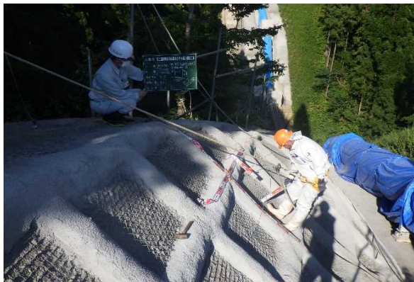
第二田沢幹線用水路北沢サイホン建設工事 法面保護工出来形確認
