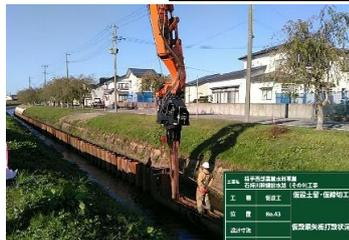
小型油圧バイプロによる打設
