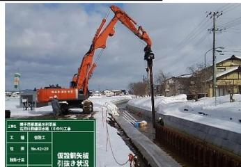
小型油圧バイプロによる引抜
