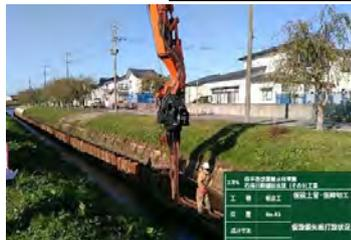
小型油圧バイブロによる打設
