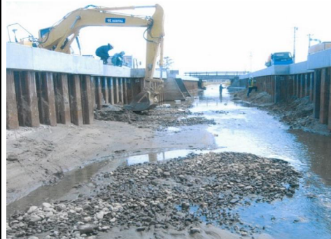
重機による堆積土砂撤去状況
