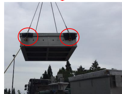
マルチアイボルトは、横吊り・斜め吊り・引き起こし作業を安全に実施できる吊り具
