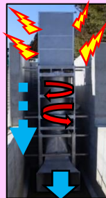
水路の右から発電設備本体へ取水し発電用の水車を回転させる（手前が上流）
