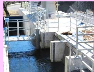
水路の右から発電設備本体へ取水し発電用の水車を回転させる（手前が上流）
