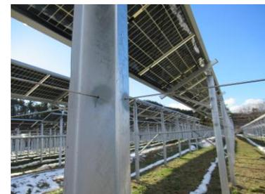
太陽光パネルの支柱を活用し、設置されたブドウ棚（鉄線部分）
