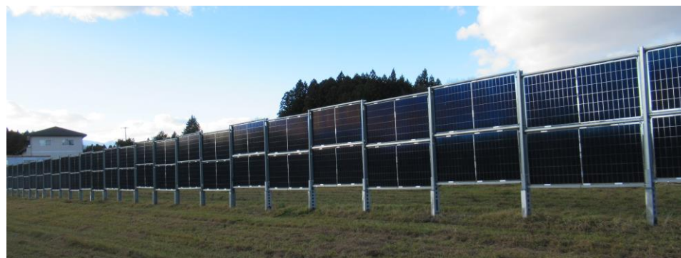
←発電施設の外観
