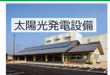
太陽光発電設備
