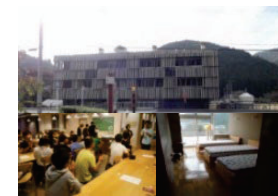
廃校を利用した交流施設
