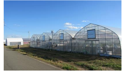
補助事業で整備したいちご研修農場
