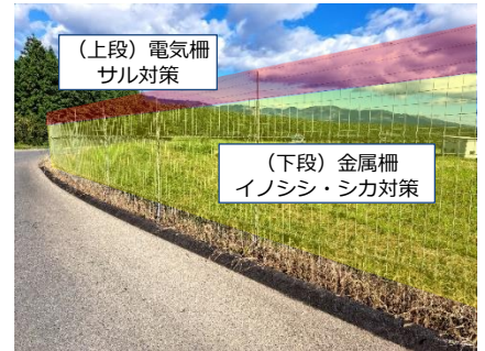
多獣種侵入防止柵（金属柵＋電気柵）
