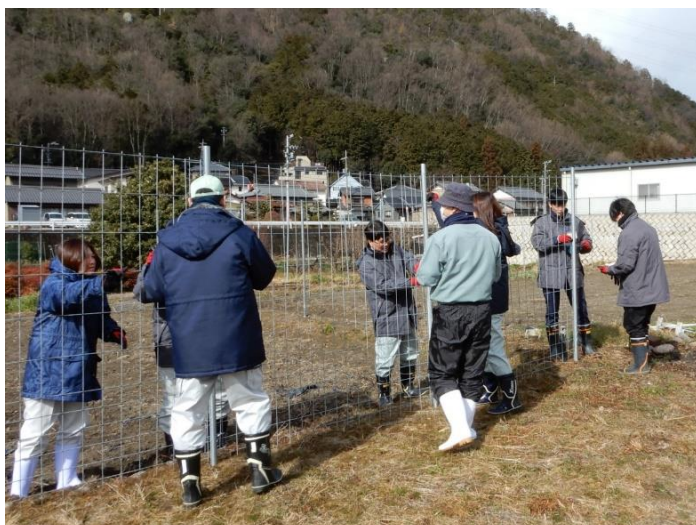
鳥獣侵入防止柵の設置作業
