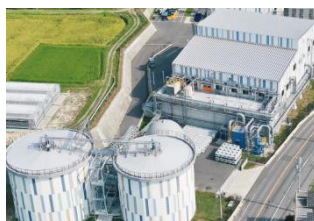
バイオガス発電プラント
