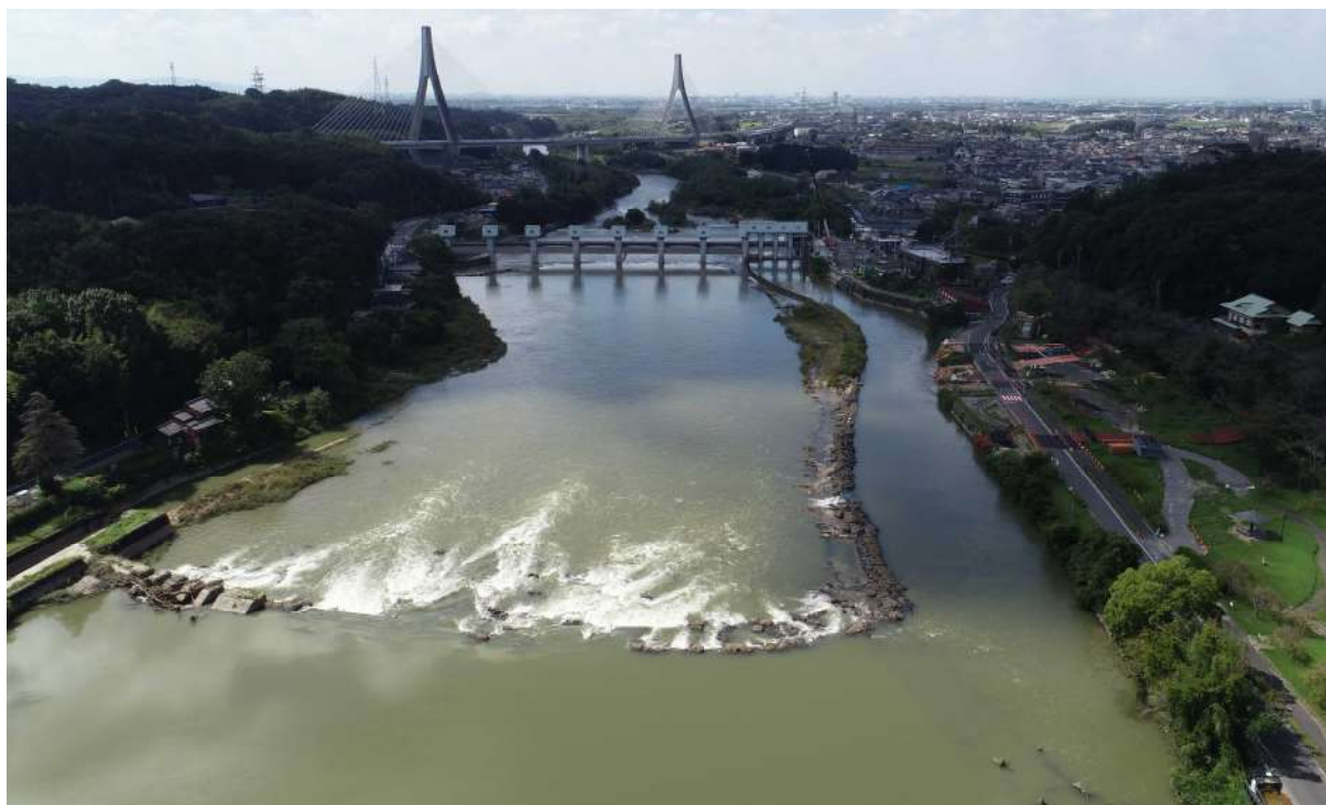
頭首工全景（上流から撮影）
