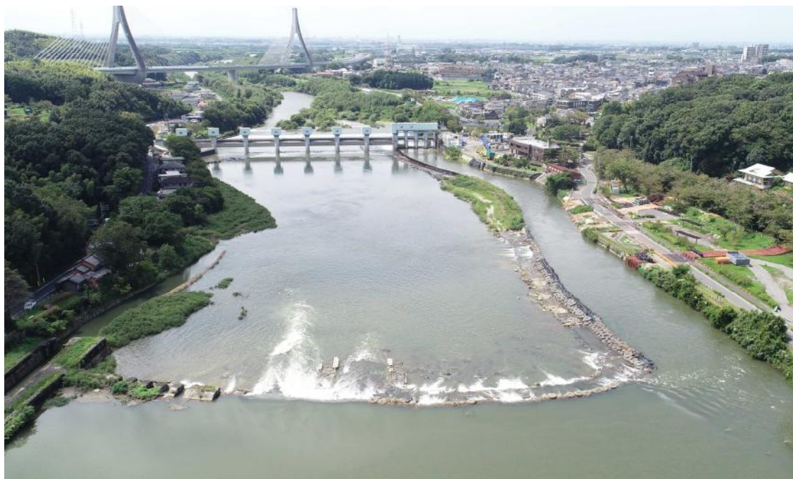
頭首工全景（上流から撮影）
