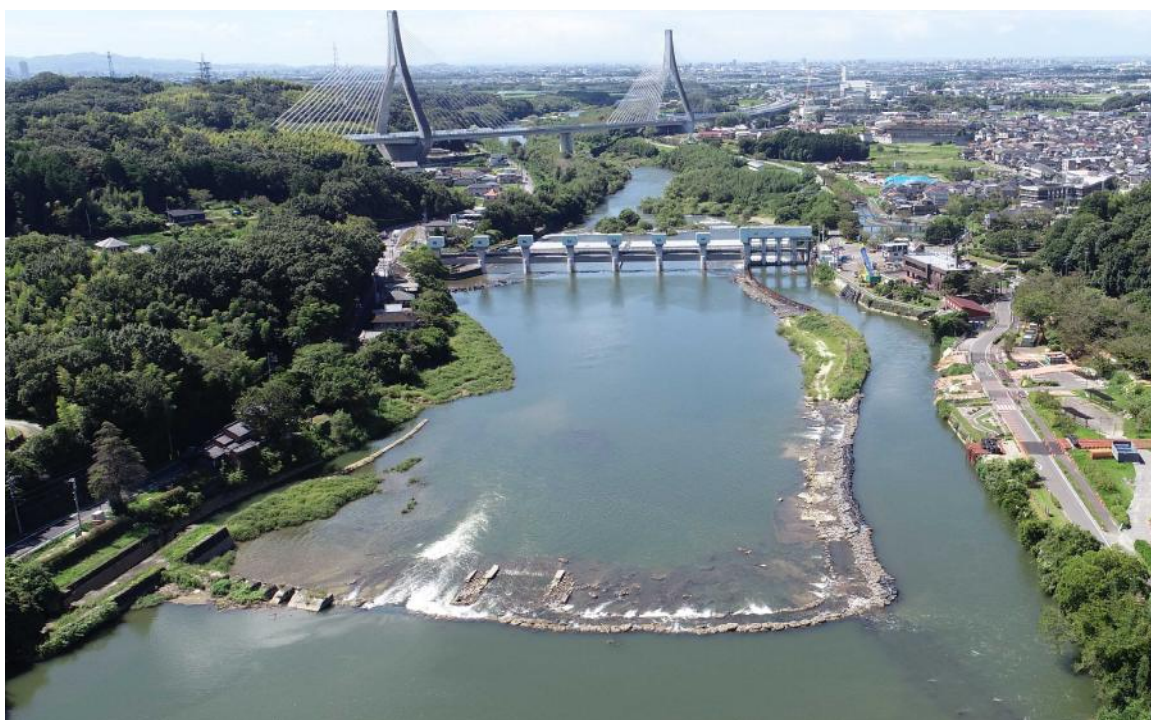
頭首工全景（上流から撮影）
