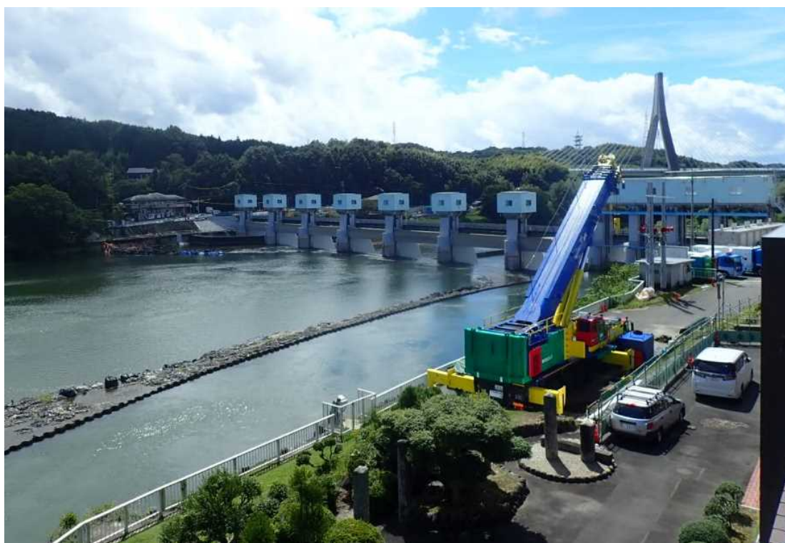
頭首工全景（右岸側から撮影）
