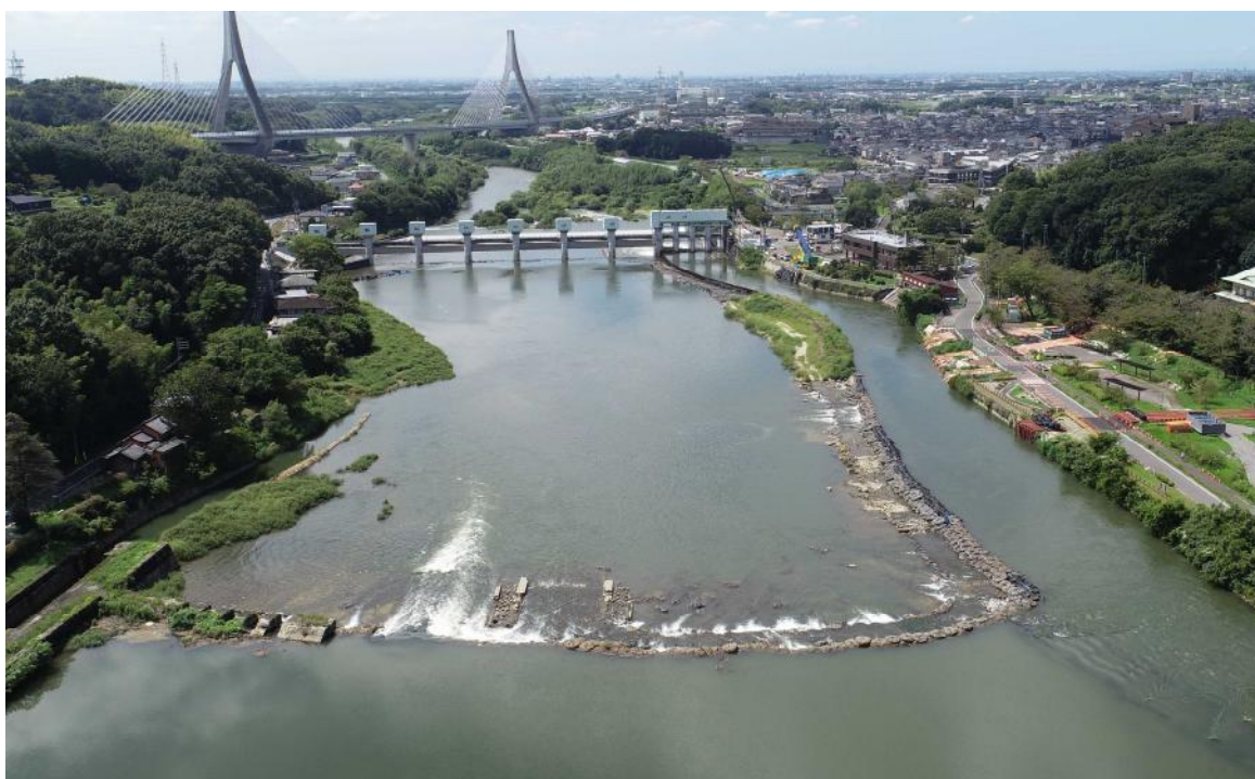
頭首工全景（上流から撮影）
