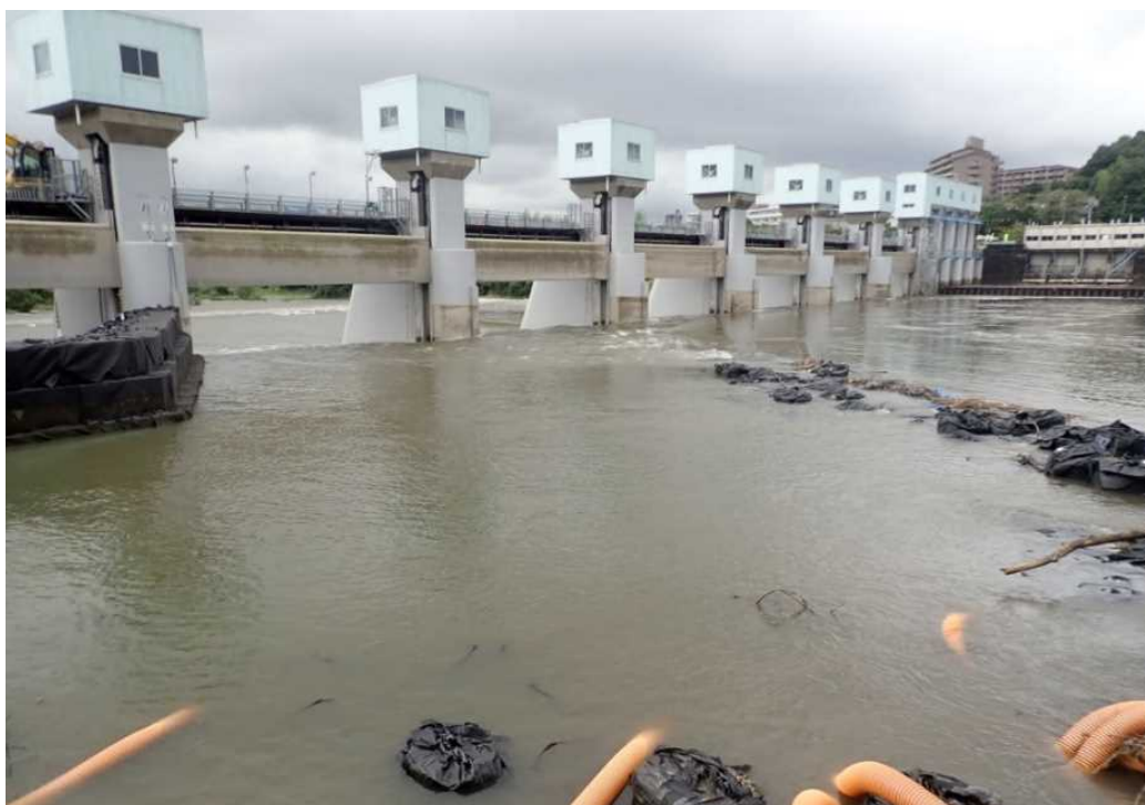
頭首工全景（左岸側から撮影）
