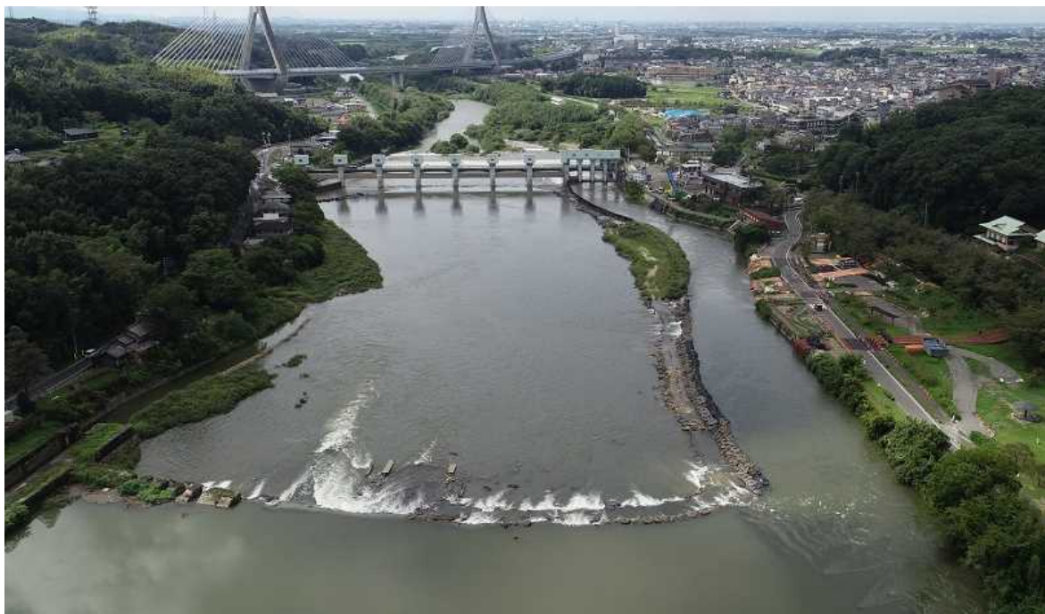
頭首工全景（上流から撮影）
