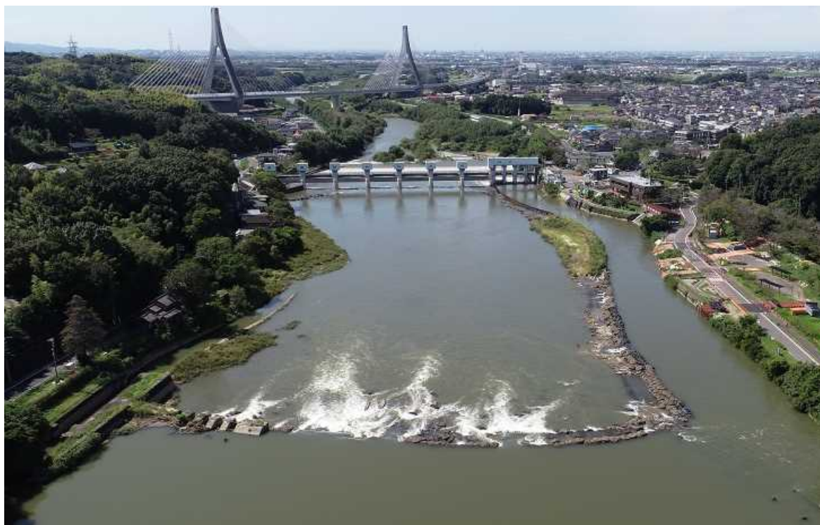
頭首工全景（上流から撮影）
