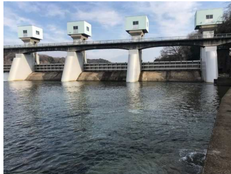
対策前（左岸下流部の流出）
