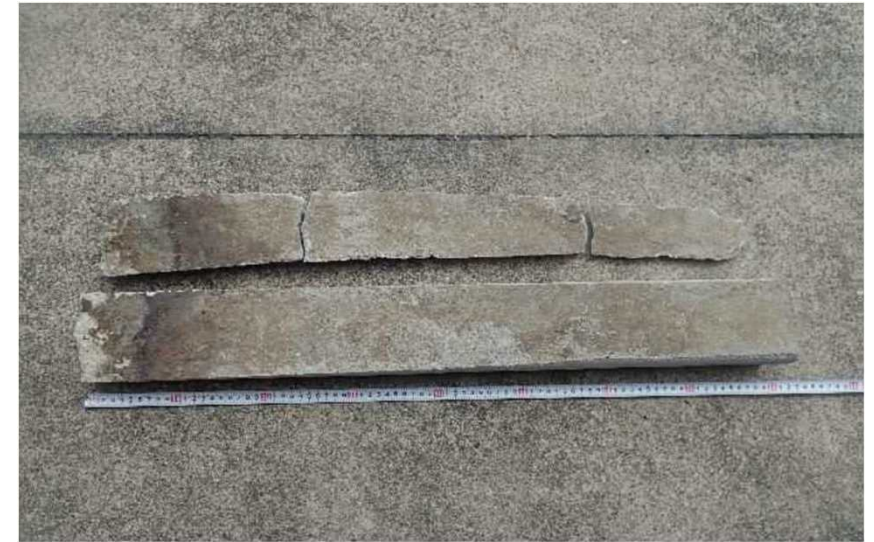
コンクリートコア（内側） 止水板 なし
