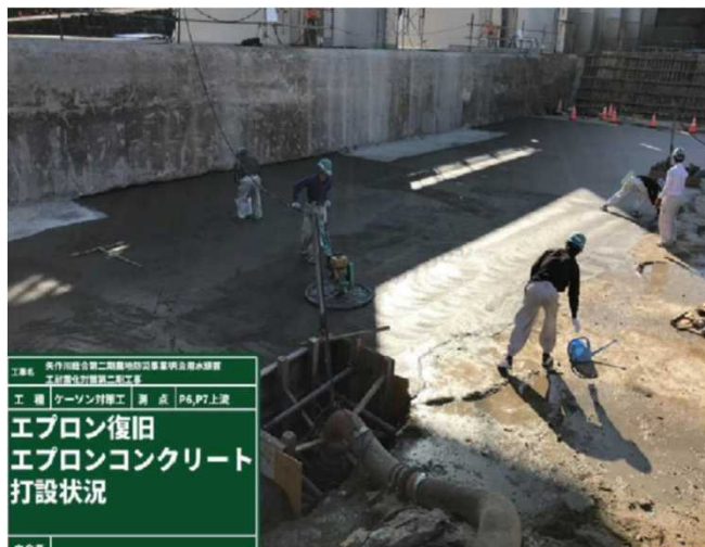
エプロン打設状況
