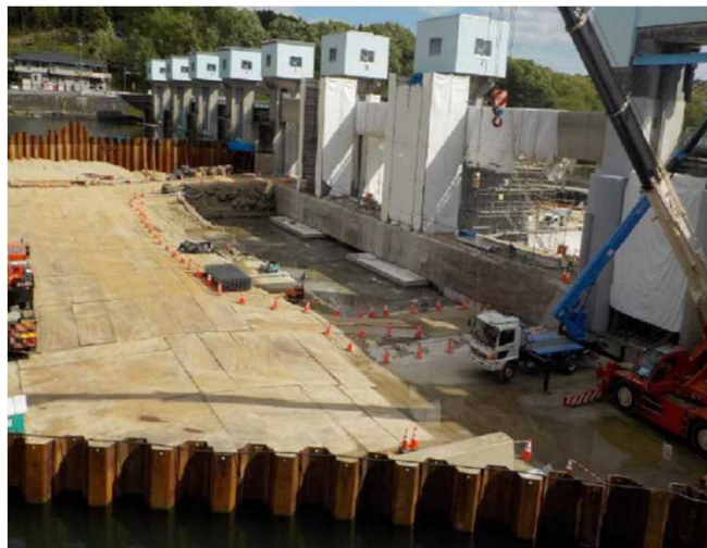
エプロン打設前
