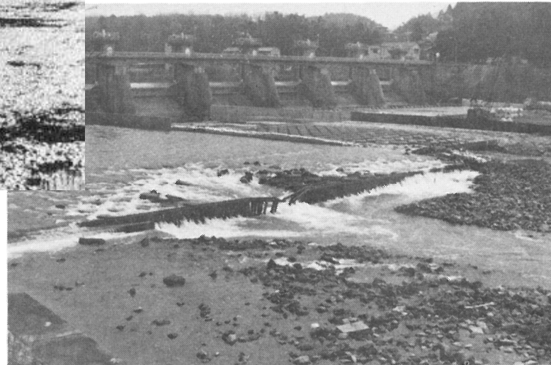
護床工の劣化状況 (沈下・破損)
