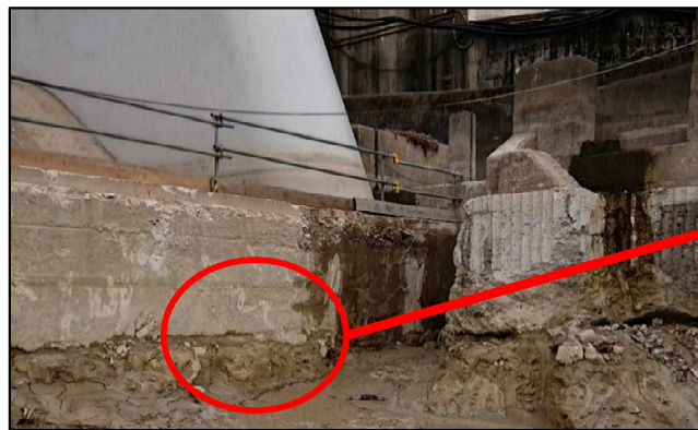
根固め工の充填状況
