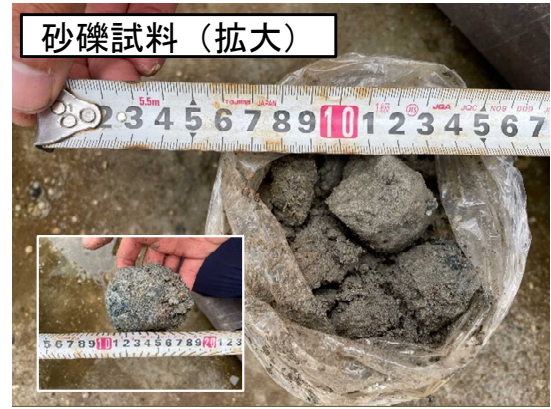
礫混じり砂層の下に0.95m (深度8.05~9.00m) の砂礫を確認。礫径は3～10cm程度。
