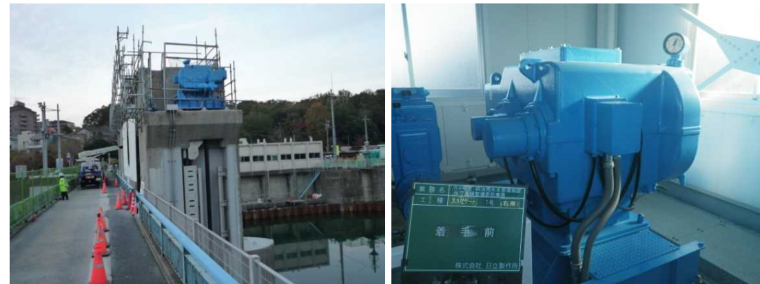
写真-開閉装置写真(施工時)
