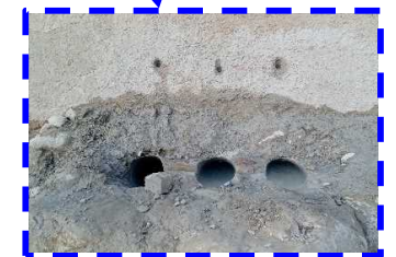
コア抜き状況
