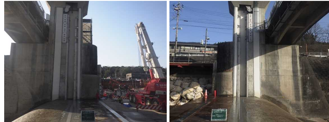
写真-戸当り写真(施工時)
