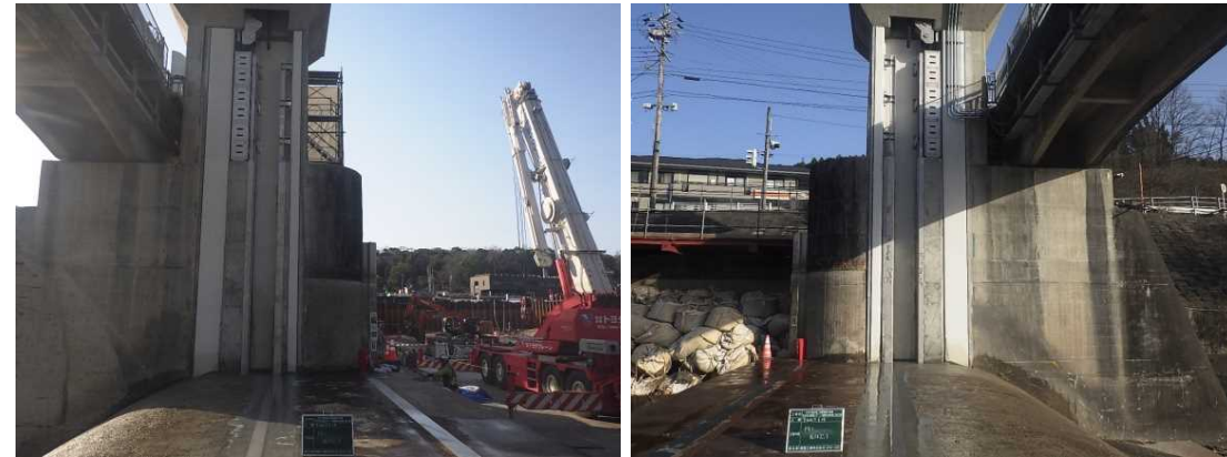
写真-戸当り写真(施工時)
