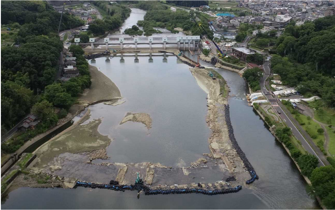
頭首工全景（上流から撮影）
