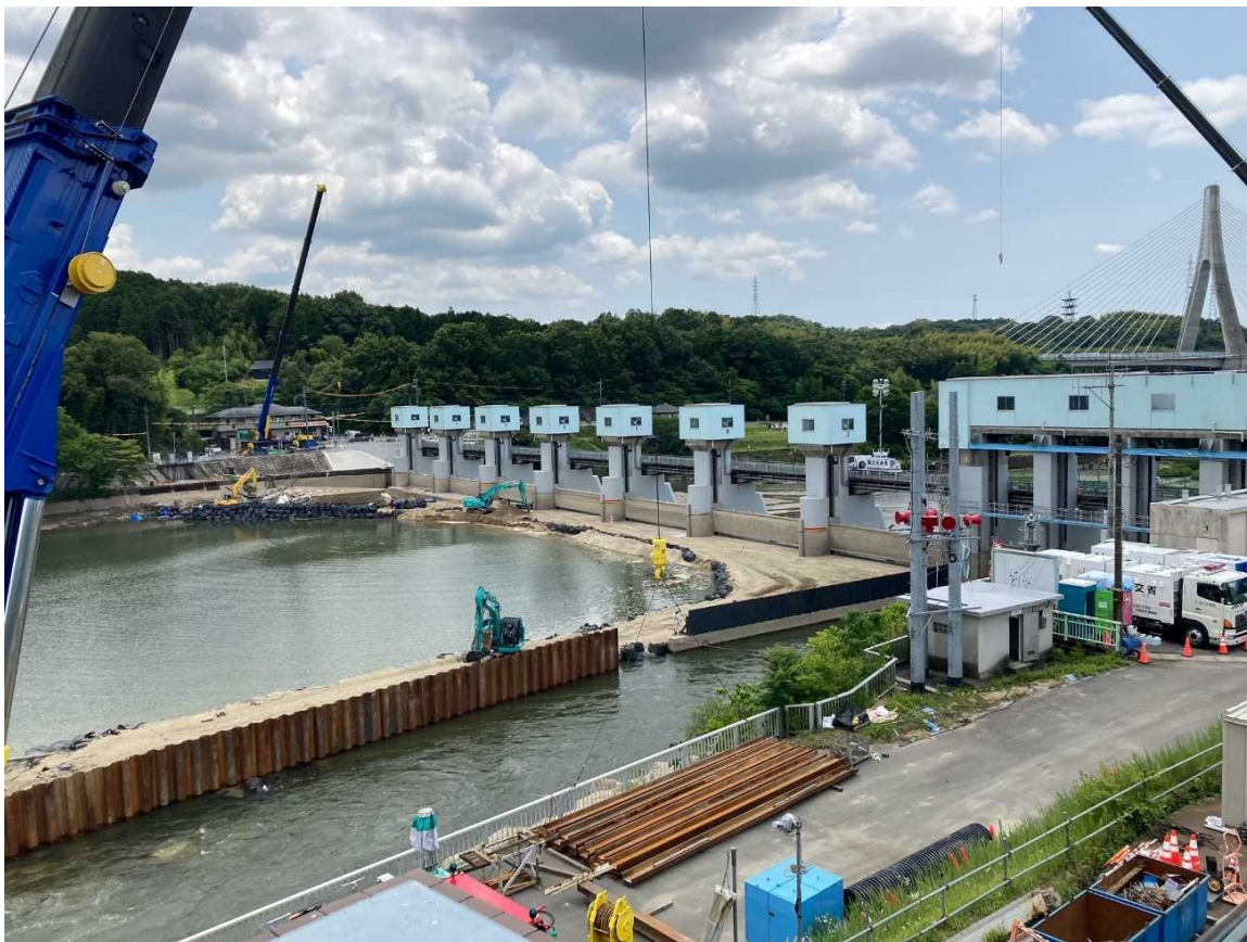
頭首工全景（管理所側から撮影）
