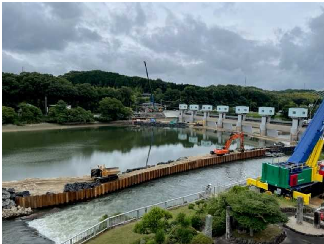
頭首工全景（管理所側から撮影）
