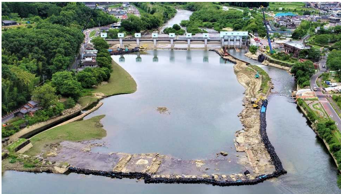
頭首工全景（上流から撮影）
