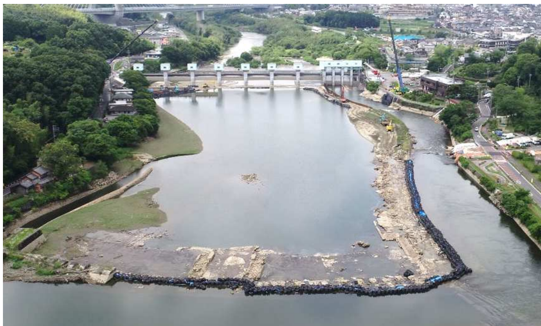
頭首工全景（上流から撮影）
