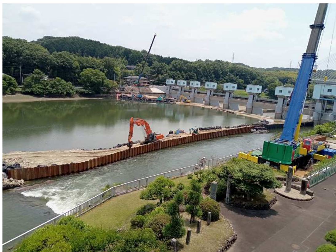
頭首工全景（管理所側から撮影）
