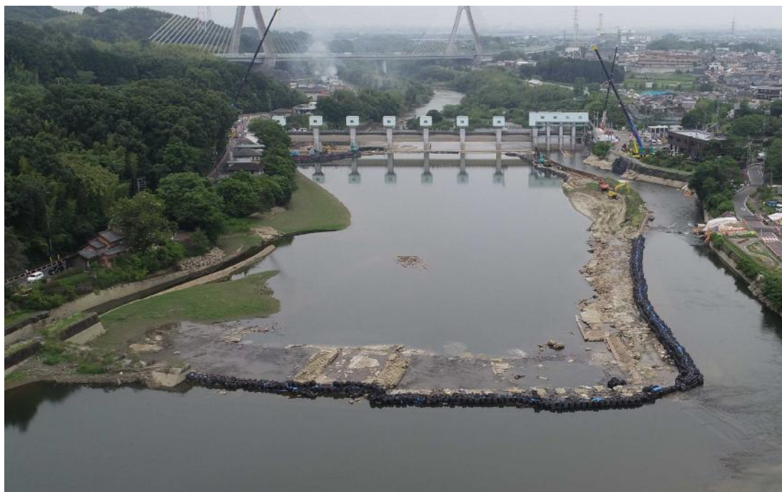
頭首工全景（上流から撮影）
