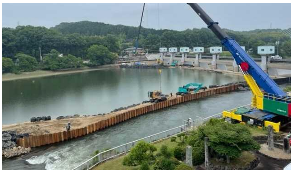
頭首工全景（管理所側から撮影）
