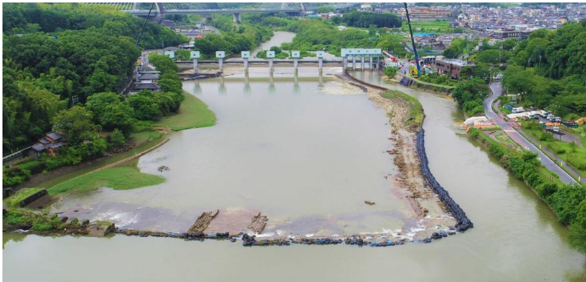
頭首工全景（上流から撮影）
