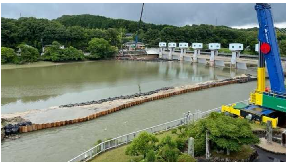
頭首工全景（管理所側から撮影）
