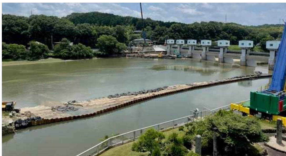
頭首工全景（管理所側から撮影）
