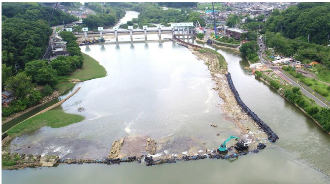
頭首工全景（上流から撮影）
