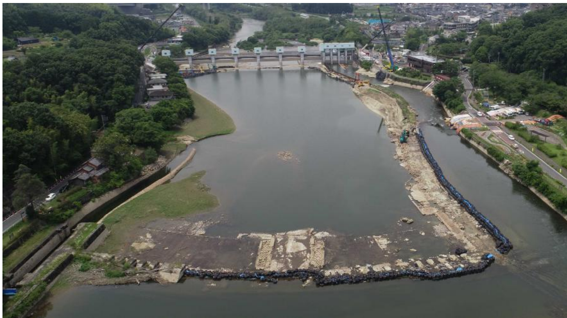
頭首工全景（上流から撮影）
