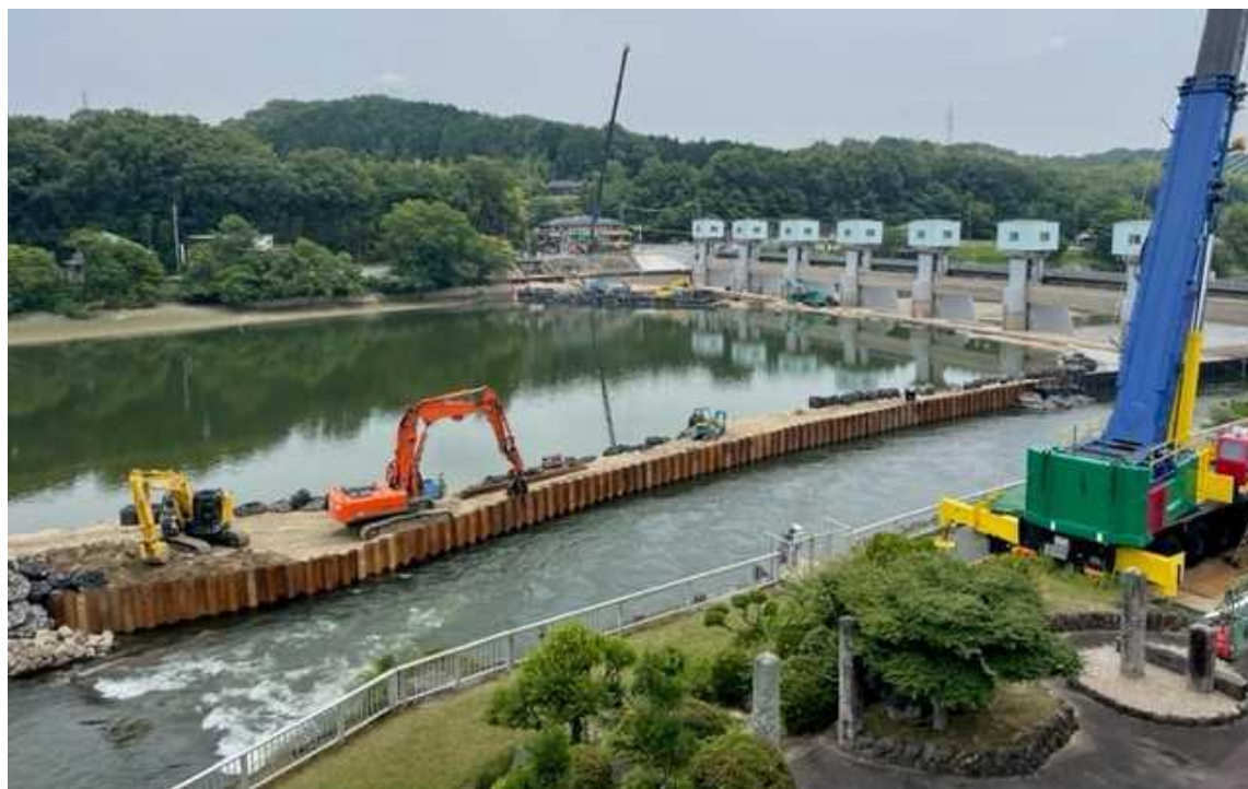
頭首工全景（管理所側から撮影）
