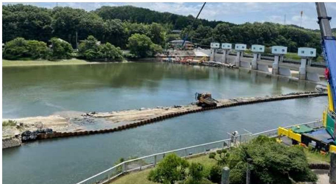
頭首工全景（管理所側から撮影）
