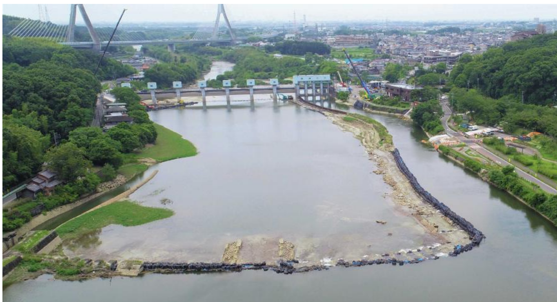
頭首工全景（上流から撮影）
